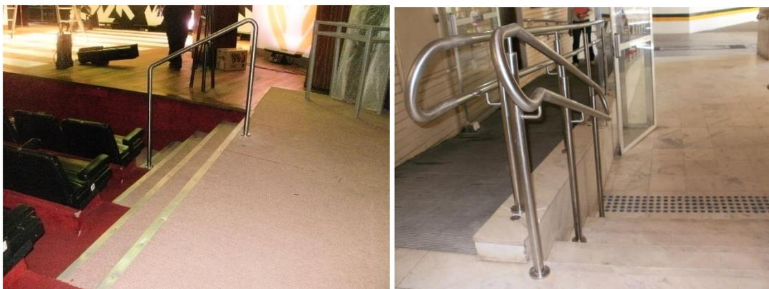
*Fotografia: corrimãos instalados de acordo com as especificações e normas.*
